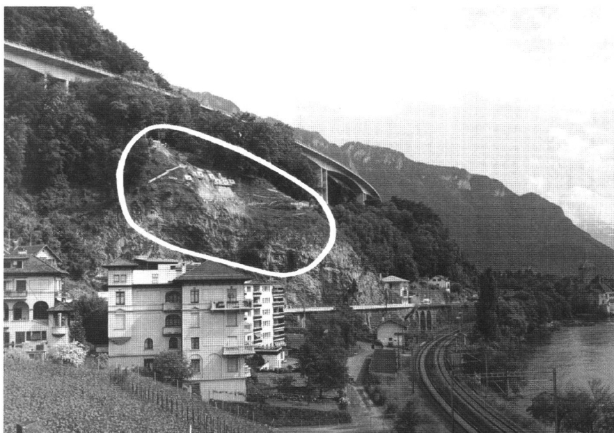
Fig. 1: L'idylle est trompeuse: peu avant Pentecôte, un glissement d'environ 100 mètres cubes de terre s'est produit près du château de Chillon à Montreux/Veytaux. A l'arrière plan à droite du château se dressent les Dents-du-Midi (3257 m), importants témoins de l'histoire de la topographie.
