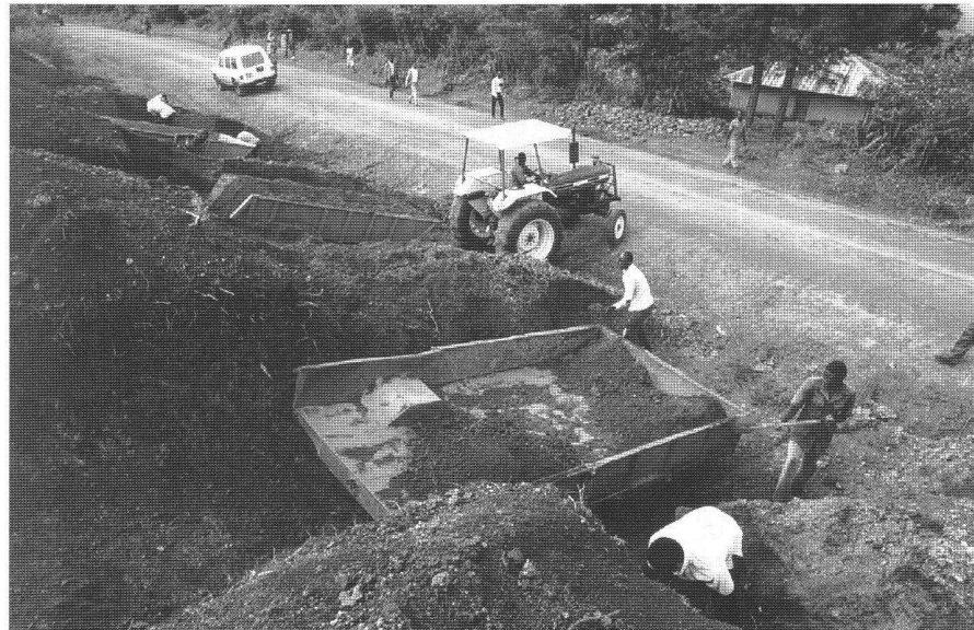
Abb. 1: Kenia, «Minor Roads Programme»; die Erschliessung strukturschwacher ländlicher Gebiete als Voraussetzung der Nutzung des landwirtschaftlichen Potentials. Seit 1975 wurden über 12 000 km Strassen mit arbeitsintensiven Methoden gebaut. Die Schweiz unterstützt das gesamte Ausbildungsprogramm. (Foto: K. Schläfli, DEH.)
