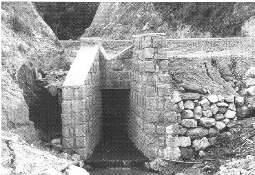
Abb. 5: Madagaskar, «Réhabilitation de la Route National 2»; Bau von Durchlässen durch lokale Kleinunternehmer, die gleichzeitig ausgebildet werden. Die praktische Ausbildung umfasst nebst bautechnischen vor allem auch administrative Abläufe wie Offerterstellung und Bauabrechnung. Regie Konsortium FRISA/Schmalz AG. (Foto: P. Peter, DEH.)
