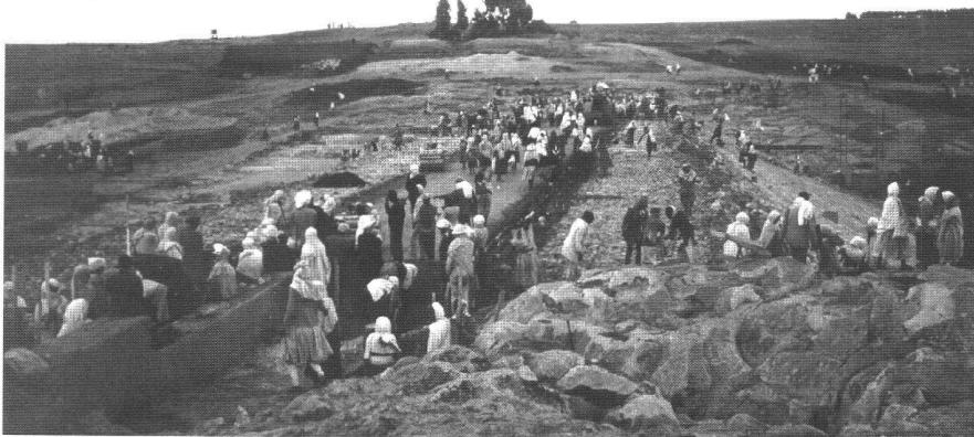
Abb. 4: Bau des Dammes bei Debre Birhan.
