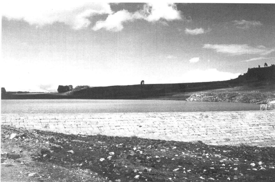
Abb. 5: Fertiger Damm mit gefülltem Reservoir.
