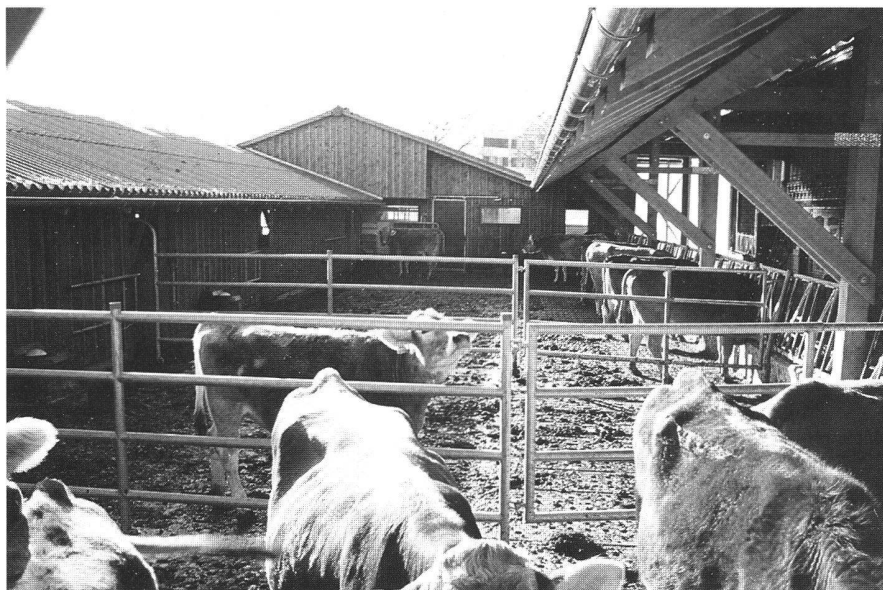
Abb. 3: Landwirtschaftlichen Hochbau in der Gemeinde Auw (AG). Neuzeitliche Lösung mit Kaltliegehalle, Laufhof und Fressplatz unter dem Vordach des teilweise erneuerten Altbaues. (Photo: F. Bubendorf, Strukturverbesserungen Aargau.)
