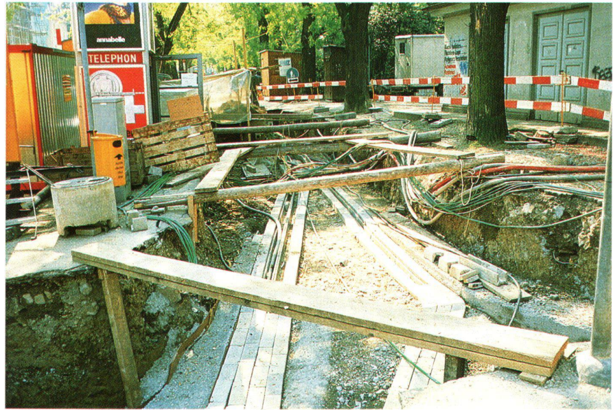
Abb. 2: Elektrizitäts-Trasseebau.
