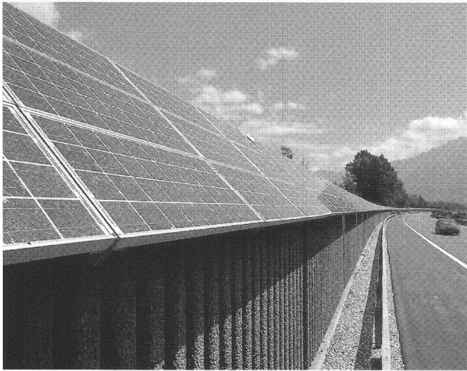
Abb. 3: Photovoltaik-Lärmschutzwand an der N 13 bei Domat/Ems.
