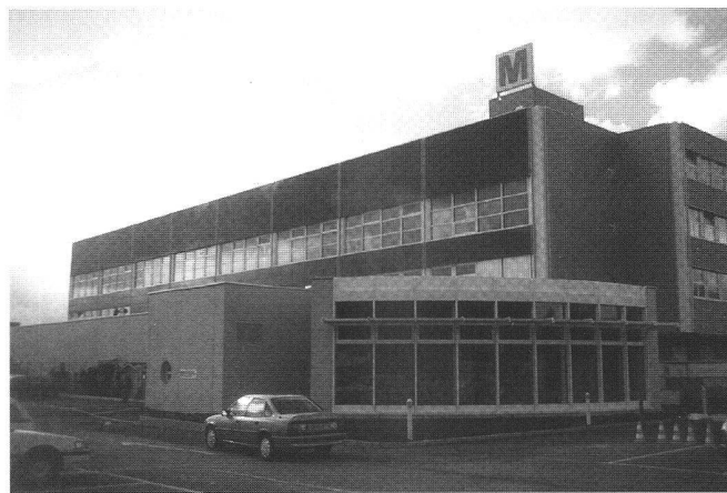
Abb. 9: Migros-Verteilzentrum Winterthur-Grüze mit fassadenintegrierter Photovoltaikanlage.
