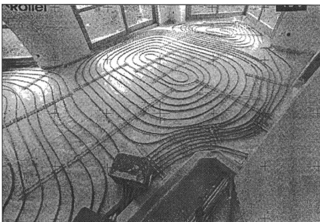
Abb. 5a: Schrägaufnahme Fussbodenheizung.
