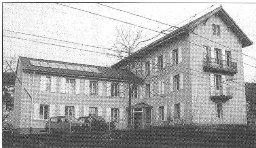
Fig. 3: Immeuble d'habitation à la rue Saint-Nicolas 22: L'assainissement réalisé en 1994 a consisté en: isolation des façades et de la toiture; remplacement des fenêtres par un double vitrage isolant avec couche sélective; préchauffage de l'eau chaude sanitaire par 18 m 2 de capteurs solaires thermiques; remplacement des calorifères individuels par une chaudière à gaz. L'économie d'énergie thermique est de 6900 m 3 de gaz/an, soit une réduction de 55% par rapport à 1993.
