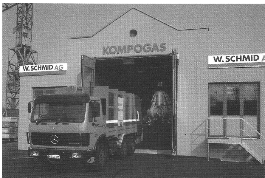
Abb. 5: Kompogasanlage in Rümlang.
