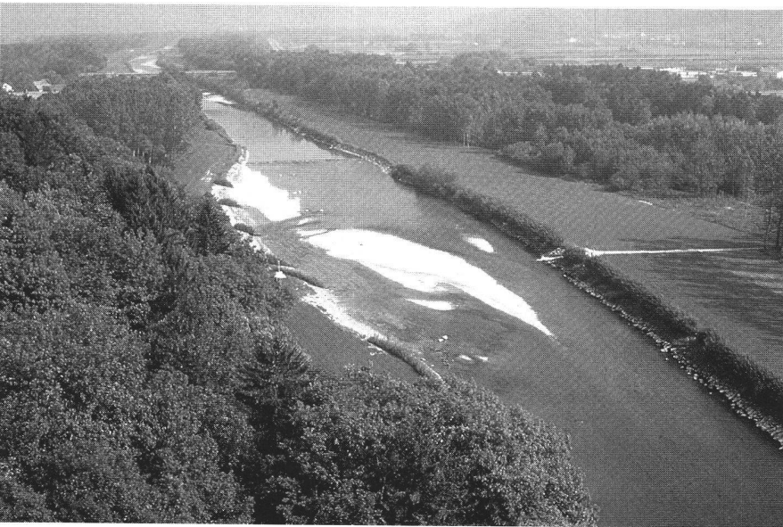
Abb. 4: Flussaufweitung an der Thur; Erhöhung der Strukturvielfalt am Gewässer.
