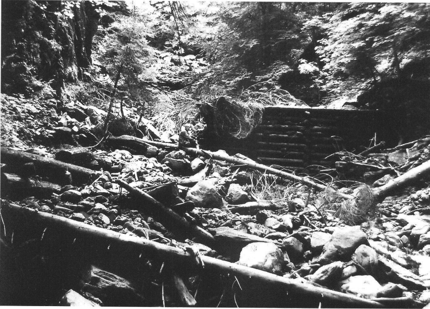
Abb. 1: Mangelnder Gewässerunterhalt; zerstörte Verbauungen erhöhen das Gefahrenpotential.
