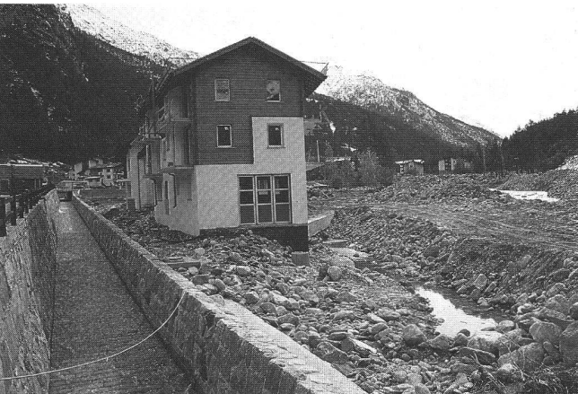
Abb. 2: Beispiel für Bauten im Gefahrengebiet ohne Rücksicht auf die Gefahrensituation.
