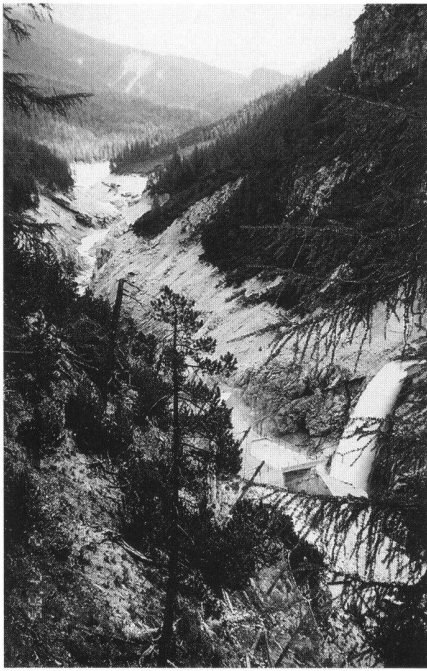
Abb. 1 und 2: Entleertes Staubecken Ova Spin, das mitten in den Schweizerischen Nationalpark eingebettet ist. Das aus der Seewurzel zufließende Spülwasser wurde mit grosser Frischwassermenge, die über den Freispiegelstollen zugeleitet wurde, effizient verdünnt. Am rechten Bildrand ist die Mündung des Freispiegelstollens mit dem abstürzenden Innwasser ersichtlic. (Foto: Engadiner Kraftwerke AG [EKW], Zernez/GR.)
