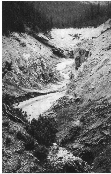
Abb. 1 und 2: Entleertes Staubecken Ova Spin, das mitten in den Schweizerischen Nationalpark eingebettet ist. Das aus der Seewurzel zufließende Spülwasser wurde mit grosser Frischwassermenge, die über den Freispiegelstollen zugeleitet wurde, effizient verdünnt. Am rechten Bildrand ist die Mündung des Freispiegelstollens mit dem abstürzenden Innwasser ersichtlic. (Foto: Engadiner Kraftwerke AG [EKW], Zernez/GR.)
