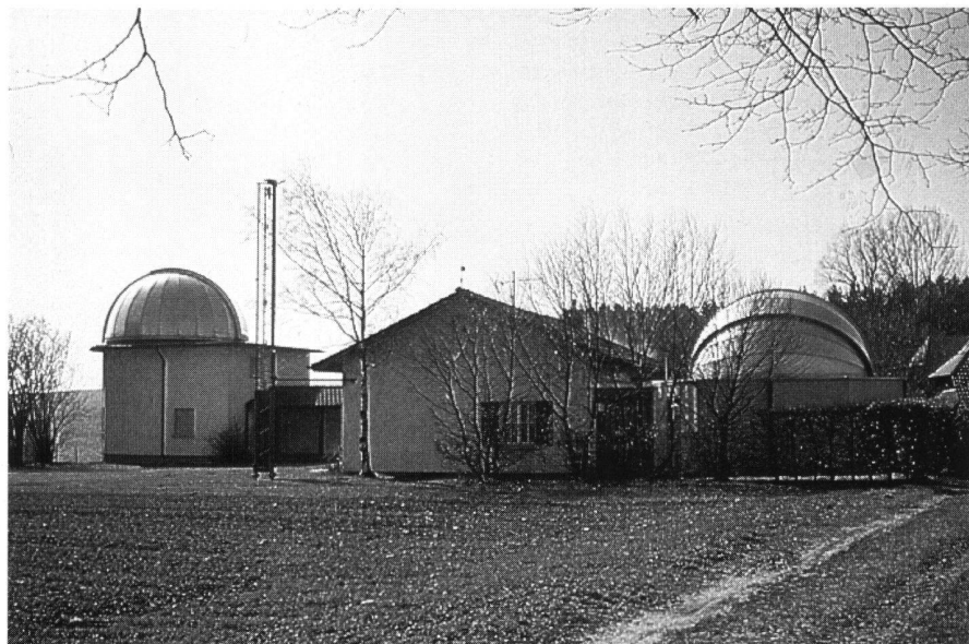
Abb. 1: Geostation Zimmerwald: Satellitenbeobachtungsstation (SLR), permanente GPS-Station.
