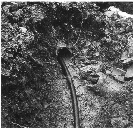
Abb. 3: Einzug des Druckschlauches in eine alte Zementrohr- und Eternit-Wasserleitung.
