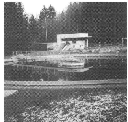
Abb. 1: ARA-Münsingen: Nutzung der Abwärme.
