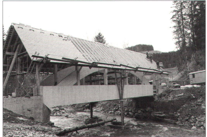
Abb. 4: Das Dach und die Brüstung schützen die Holzkonstruktion vor der Witterung (Fotos: H.U. Siegenthaler, Schangnau).
