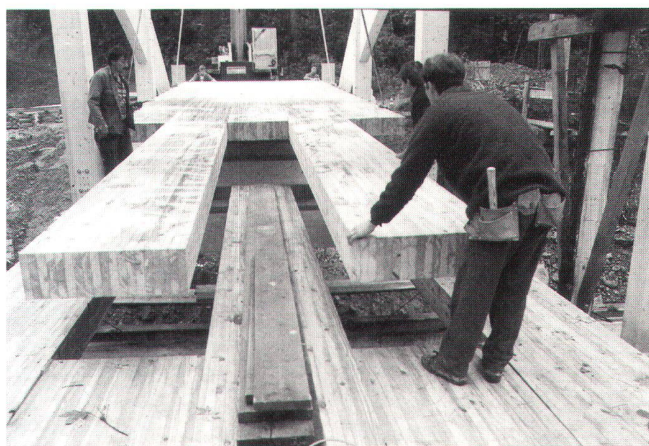
Abb. 2: Die vorgespannte Fahrbahnplatte wird auf die Querträger gelegt. Die Verzahnung der Fahrbahnplatte verleiht Stabilität.
