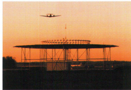
Abb. 1: VOR/DME Station Kloten. Die Antenne der DME-Anlage ist als Stab in der Mitte des (VOR) Antennenkranzes sichtbar (Foto: Christoph Zehnder, swisscontrol).
