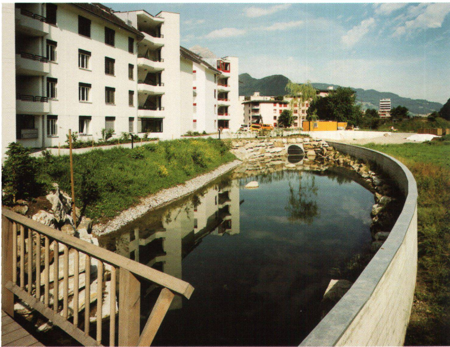
Abb. 2: Durch CAD-Einsatz erweitert sich das Aufgabenfeld des Ingenieurbüros allgemein um Dienstleistungen im Rahmen langfristiger kommunaler Konzepte. Im Bild: Retentionsbecken für Regenwasserzufall zur Regulierung von Abflussspitzen in der Gemeinde Stans, ein weiteres Projekt der Desserich + Partner AG.
