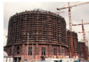
Abb. 6: In den Zylindern des grössten Gasometerkomplexes Europas entstehen Hochhäuser.
