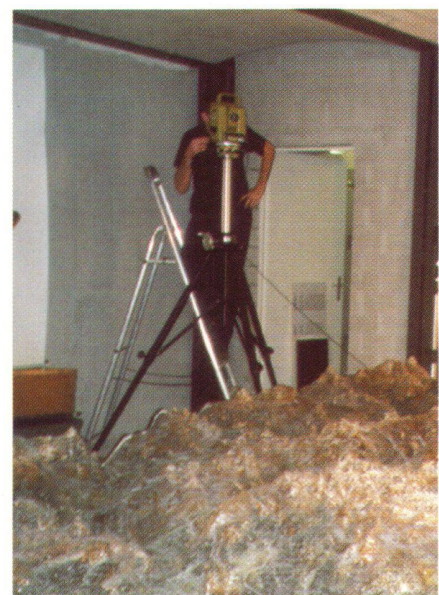
Abb. 4: Trigonometrische Passpunktbestimmung.
