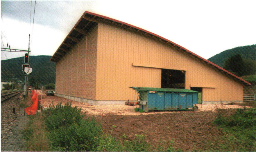
Abb. 3: Moderne Ökonomiebaute in gewagtem Design in Sonceboz. Wie weit soll die Amtsstelle Mitverantwortung für den Ortsbildschutz übernehmen?
