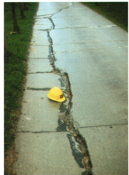
Abb. 4: Betonweg Stägmatte bei Brienz. Die Werkserhaltung im Wegebau gewinnt stark an Bedeutung, die Abteilung Strukturverbesserungen ist beauftragt, den Unterhalt zu überwachen.
