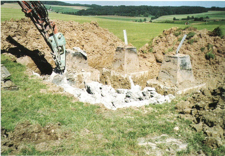
Abb. 2: Abbruch eines Trägermastens: Separierung Ober- und Unterboden, Abbruch des Betonssockels.
