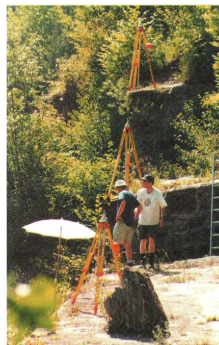
Abb. 1: Vermessungsarbeiten im Gelände.
