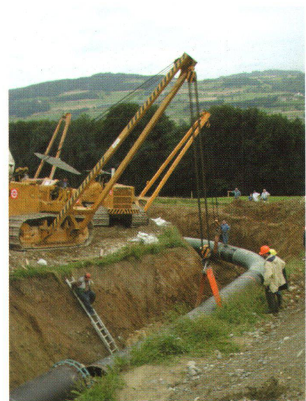
Abb. 1: Der Absenkvorgang der tonnenschweren, verschweissten Rohrleitung ist ganz besonders anspruchsvoll. Bei dieser Arbeit werden von den sogenannten Seitenbäumen die höchsten Auflagedrücke, die auf den Boden wirken, erzeugt (Foto Judith Burri).
