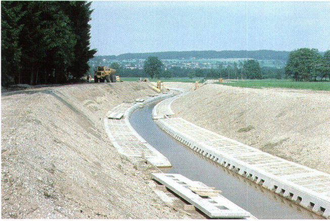
Abb. 1: Bau des Vorflutkanales A5 (1978).
