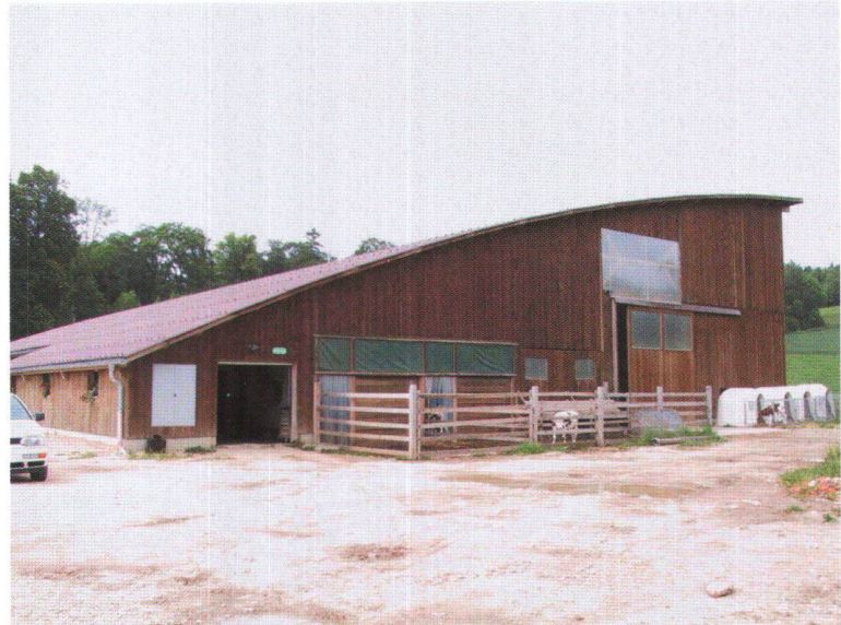
Abb. 9: Die neue Scheune für das Milchvieh der Betriebsgemeinschaft zweier Landwirte ist hoch beim Futterlager und niedrig im Stallteil. Mit dem optimalen Gebäudequerschnitt können Kosten gespart werden.
