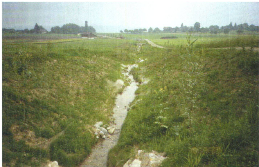
Abb. 12: Der offen gelegte Moosbach bildet eine ökologische Vernetzung und bereichert die Landschaft.
