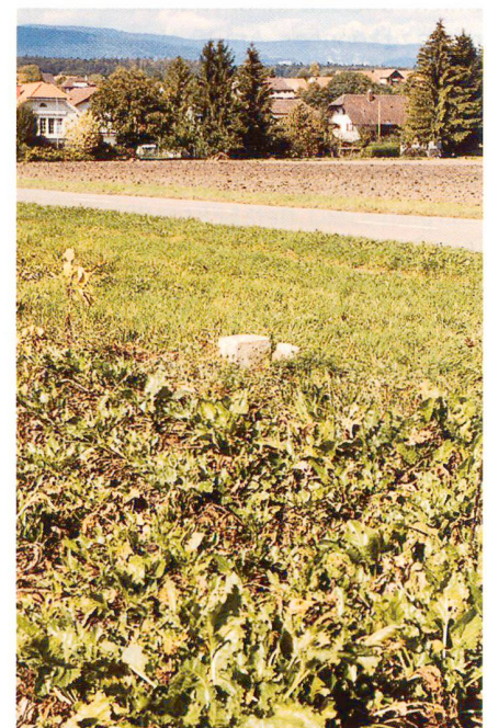
Abb. 8: Heutiger Zustand des Basisendes in Walperswil. Der sichtbare Granitstein wurde 1927 zusammen mit dem ursprünglichen Markierungsstein unter der Oberfläche in eine massive Betongrundplatte einbetoniert. Von den ursprünglich vier Versicherungssteinen (siehe Kontrollblatt Landestopografie) im Abstand von vier bis fünf Metern ist keiner mehr vorhanden, der letzte liegt hingeworfen an der Oberfläche.
