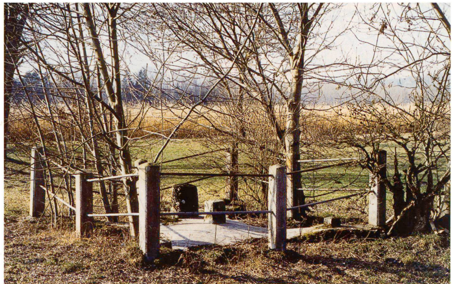
Abb. 7: Heutiger Zustand des Basisendes in Galmiz (Sugiez). Hauptsteine und Versicherungssteine (letztere mit einbetoniert) sind vorhanden und «im Blei». Das umliegende Terrain ist massiv abgesunken (schwarzer Torfboden), vor allem auch die vier mittleren Stützen der Einfriedung. Nicht beurteilbar ist die gesamte Absenkung nach der Juragewässerkorrektur in dieser Gegend. Sie könnte durchaus mehr als einen Meter betragen.
