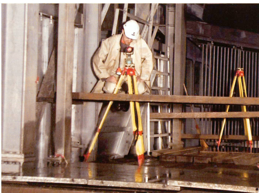
Abb. 2: Positionierung der Stative am Schachtfuss.
