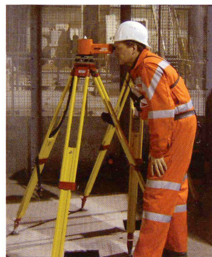
Abb. 1: Nadirlot am Schachtkopf.
