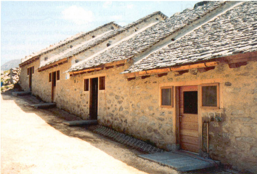
Abb. 3: Vorbildliche Sanierung der Alpe Steggia (Medel/Lucmagn GR). Zusammenarbeit zwischen Meliorationsamt, Denkmalpflege und SL. (Foto: SL.)
