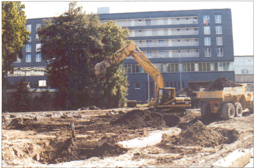
Abb. 1: Altlastensanierung Zürich Nord.
