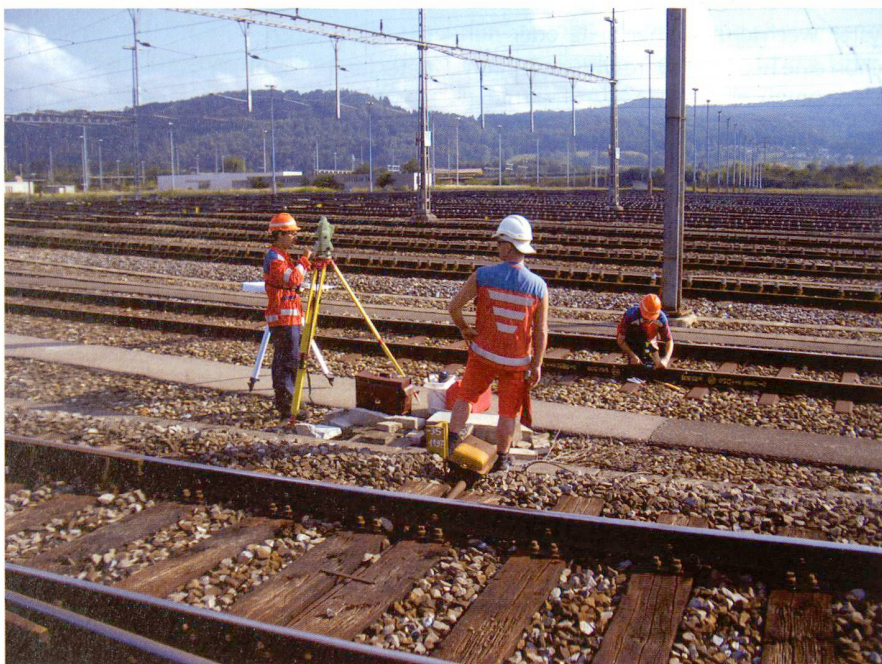
Abb. 1: Geomatikteam mit Sicherheitswärtner bei Absteckungsarbeiten.
