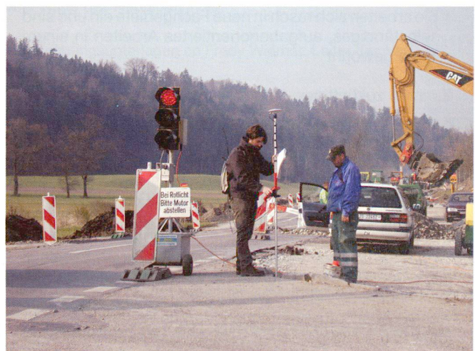
Feld, GPS Feldvermessungsinstrument.
