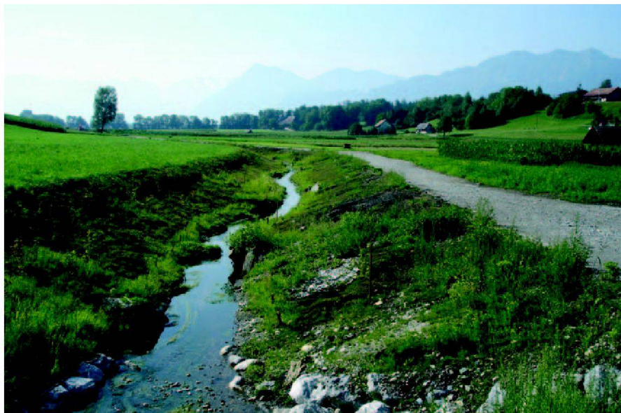
Abb. 2: Nach der Renaturierung: Der neue Limpach (Kronenbreite 12 m, Gefälle 1.2 Promille) mit Uferweg, die neu gesetzten Hecken sind noch schlecht sichtbar.
