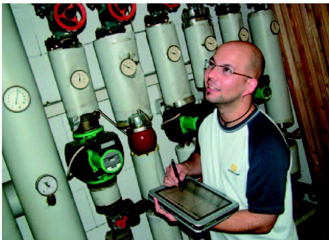
Mobiler Arbeitsplatz LIDS iView bei der Kellerbegehung.
