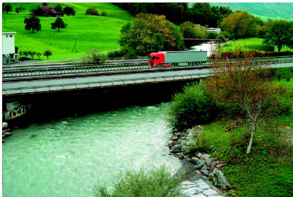
Abb. 5: A2-Brücke und Wildübergang über das Aawasser in Buochs. (Foto: F. Businger.)
