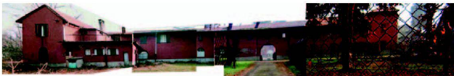
Fig. 10: Vue extérieure Ouest, avec l'entrée depuis les «Nouvelles Maisons».
