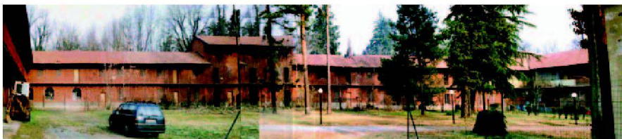
Fig. 11: Vue intérieure Nord.
