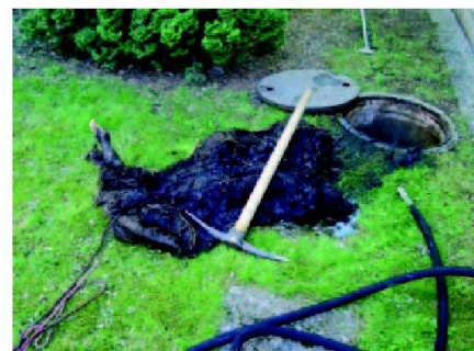
Abb. 4: Jeder Unterhalt beginnt mit dem Reinigen der Schächte.
