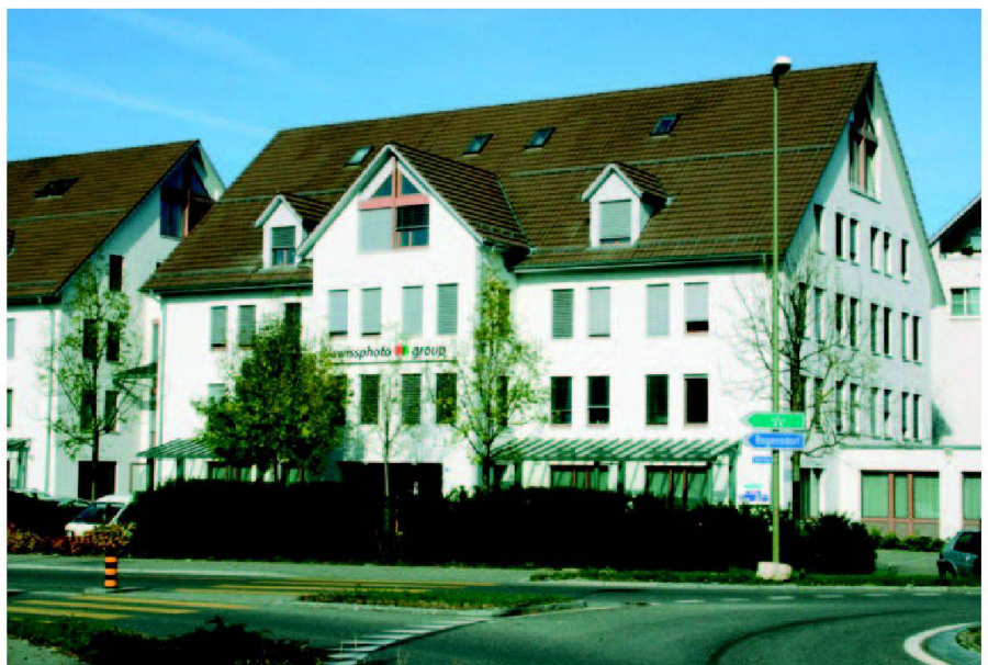
Abb. 1: Hauptsitz der Swissphoto AG in Regensdorf.
