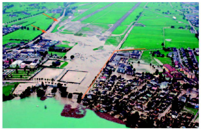
Abb. 2: Die Engelberger Aa in der Ebene zwischen Ennetbürgen und Buochs während des Hochwassers Ende August 2005. Die Pfeile bezeichnen zwei der drei Entlastungsstellen; rechts der im Bau stehende Sekundär-Damm zum Siedlungsgebiet (© Schweizer Luftwaffe).
