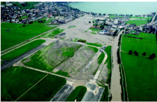
Abb. 1: Die Engelberger Aa in der Ebene zwischen Ennetbürgen und Buochs während des Hochwassers Ende August 2005. Gut zu sehen sind die Entlastungsstellen, an denen das Hochwasser kontrolliert die Ebene überfluten kann (© Schweizer Luftwaffe).
