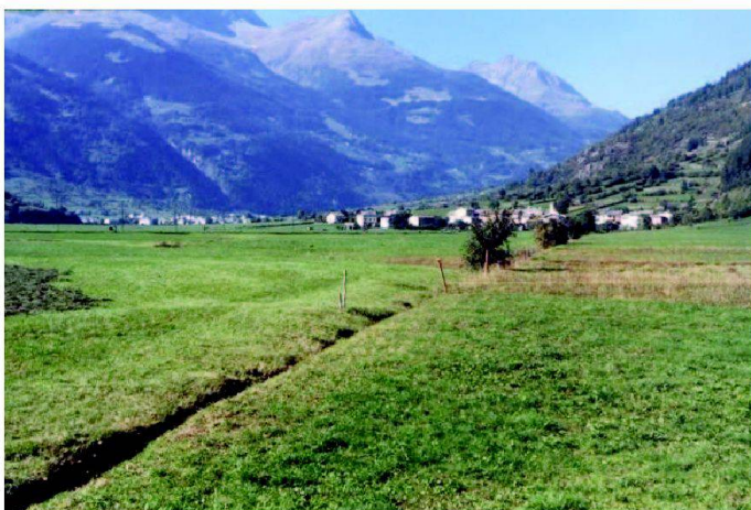
Abb. 2, 3 und 4: Mit der Revitalisierung und dem Tieferlegen der Entwässerungsgräben wurde die Vorflut gesichert, die Landschaft aufgewertet und ein Laichgewässer für die aus dem Lago di Poschiavo aufsteigenden Forellen geschaffen.
