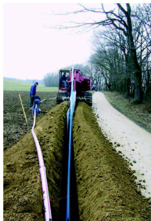
Fig. 4: Pose à la trancheuse des tuyaux de refoulement.
