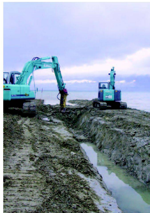
Fig. 3: Travaux de fouille pour la pose de la conduite d'alimentation reliant la prise d'eau à la station de relevage.
