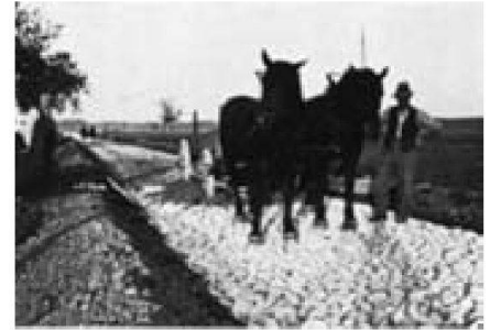
Abb. 2: Güterzusammenlegung in Utzenstorf: Wegebau, 1930.
