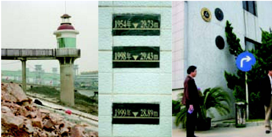
Abb. 1: Im Umbau befindliche Uferverbauung in Wuhan mit hydrologischer Station; im Hintergrund den Pegelschwankungen angepasste Piers (links); Hochwassermarken an der Verbauung entlang des Changjiang in Wuhan (Mitte) und die entsprechenden Marken am Geb ude des CWRCs (rechts); deutlich erkennbar ist, wie stark Wuhan von den Hochwassern betroffen war, bevor die neuesten Hochwasserschutzmassnahmen erfolgt sind (  MFB-GeoConsulting).
