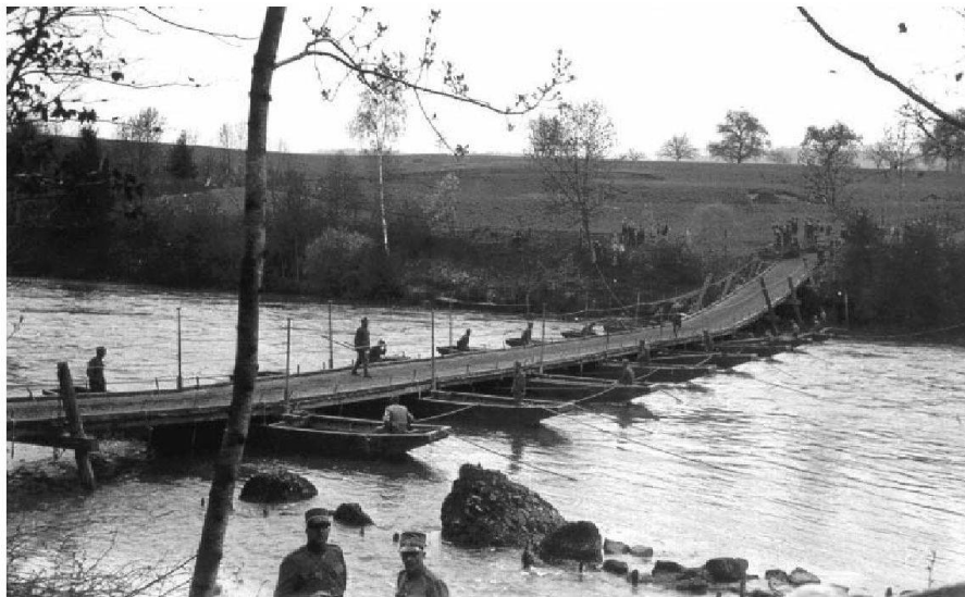
Abb. 10: Schweizer Armee: Pontonier-Bataillon 3. Einbau der Birago-Brücke im WK 1934. Feste und schwimmende Auflager kombiniert. Überwindung eines Steilufers (BAUT 2002).
