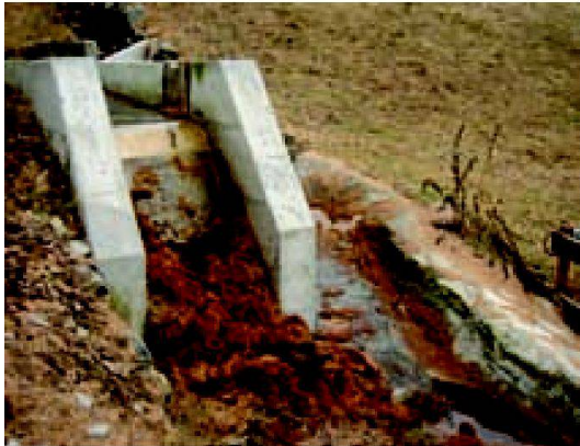
Abb. 3: Moderne Kleinwasserfassung an einer Suone, am Beginn einer ortsfesten Beregnungsanlage.
