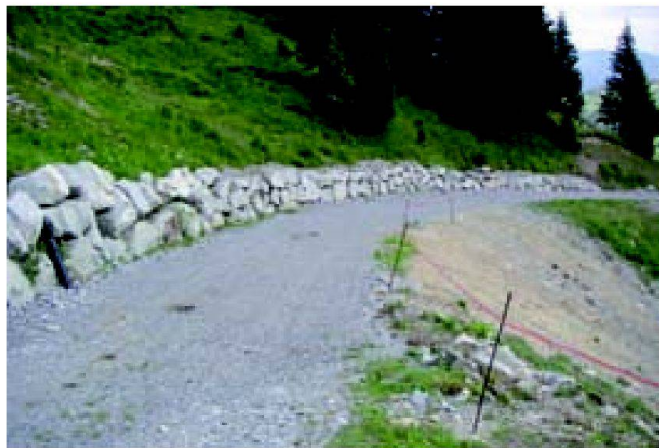
Abb. 2: Wiederherstellung eines Güterwegs mit rekultivierter Böschung, Lenk (BE).
