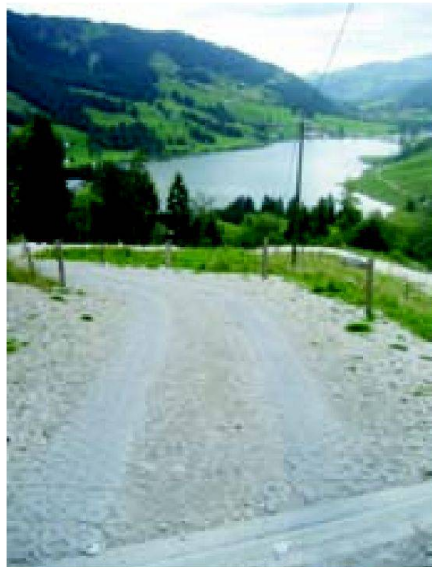
Fig. 5: Chemin d'accès à l'alpage de la Breccaschlund (Lac Noir FR) en bandes de roulement avec des pavés ajourés en béton et des éléments préfabriqués (au premier plan) pour l'évacuation des eaux de surfaces.
