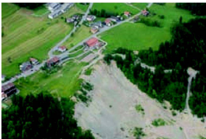
Abb. 1: Hangrutschung Doren in Vorarlberg (Foto: Gernot Kobltschnig).
