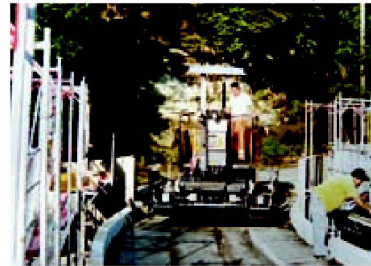
Abb. 2: Belagseinbau Rossgrabenbrücke (Sommer 2005).
