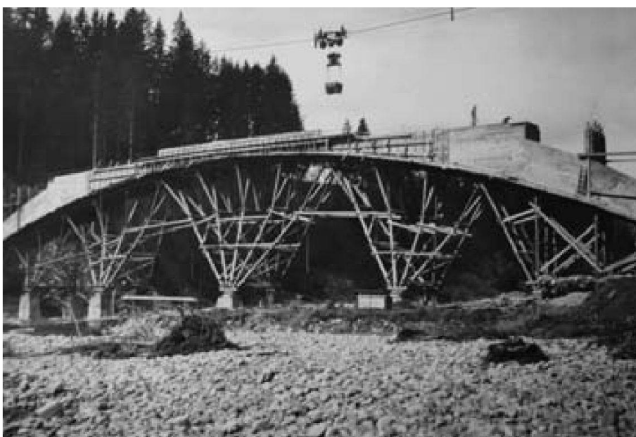
Abb. 1: Bauausführung Rosigrabenbrücke mit Lehrgerüst und Bauseilbahn (Aufnahme vom 10. Oktober 1932, aus Archiv ASP-BE).
