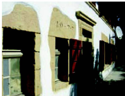
Abb. 2: Rothaus, ehemalige seeseitige Fassade.
