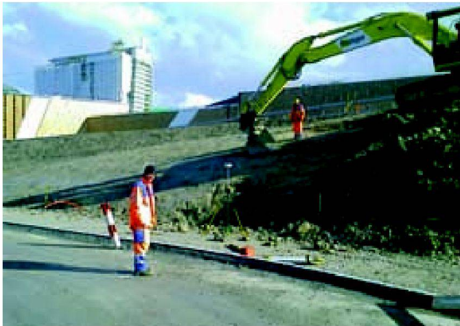
Abb. 5: Trimble 5800 GPS Receiver im Einsatz.
